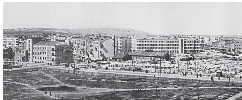
Рис. 1. Начало строительства клуба им. Максима Горького. В центре снимка видны бетонитовые камни. Слева — дом приезжих СТЗ. 1931 г. [4]
