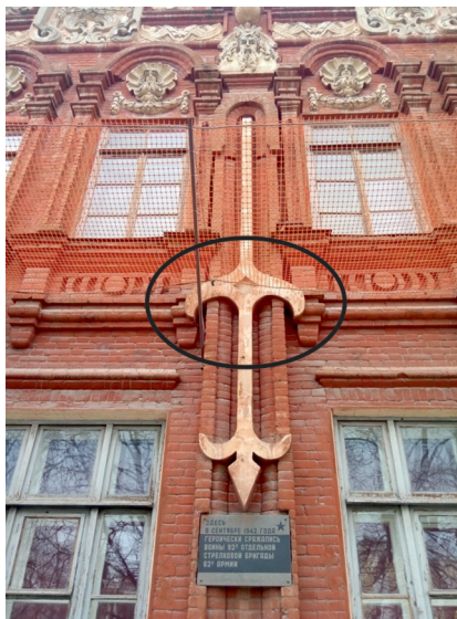
Рис. 6. Эволюция устройства пик на фасадах здания: а) главный фасад (северный), б) западный фасад (по ул. Рабоче-Крестьянской)
